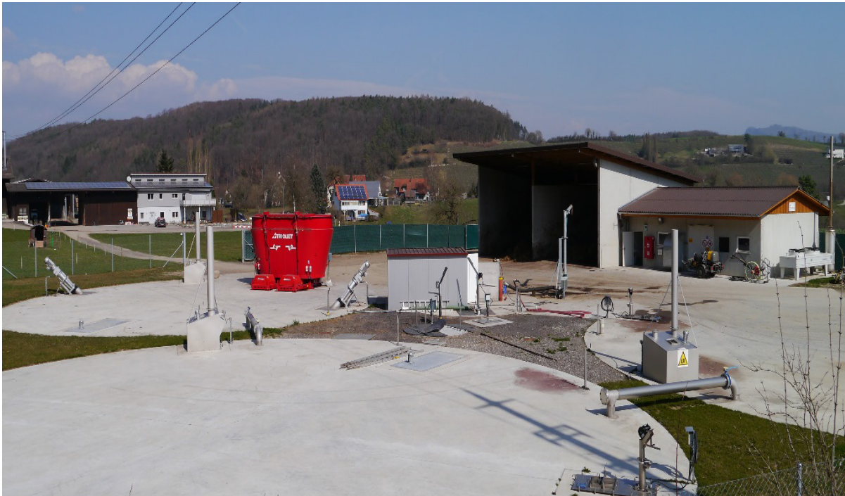
Abbildung 9: Blick auf die Biogasanlage mit den unterirdischen Gärbebehältern
