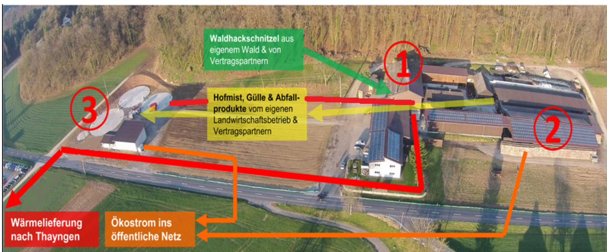
Abbildung 10: Luftbild des Landwirtschaftlichen Betriebs «Unterbuck» in Thayngen (SH) mit Holzsnitzelfeuerung (1), Photovoltaikanlage (2) und Biogasanlage mit Blockheizkraftwerk (3).
