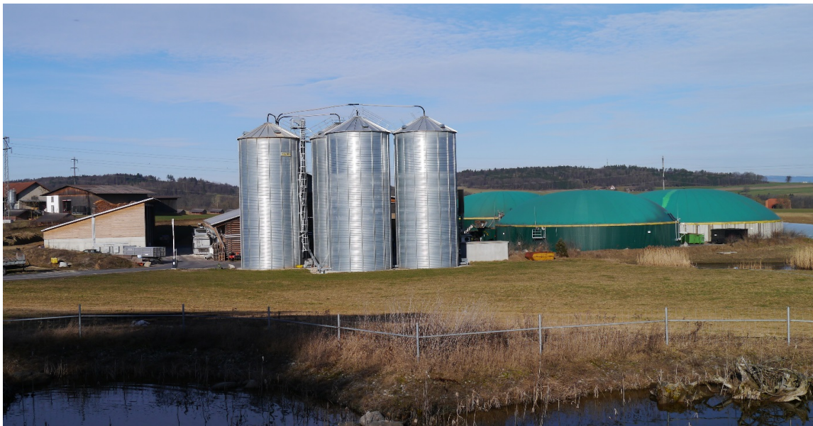
Abbildung 13: Bioenergiepark Düringen mit Lagertanks für getrocknete Holzpellets und der Biogasanlage
