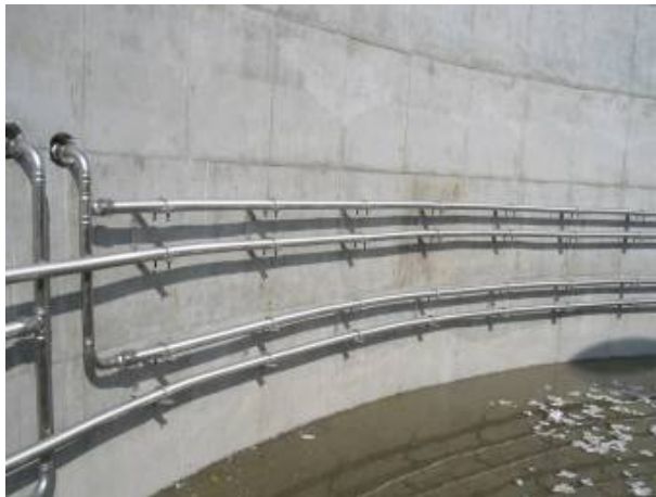
Abbildung 1: Interne Heizschlangen an der Fermenterwand
