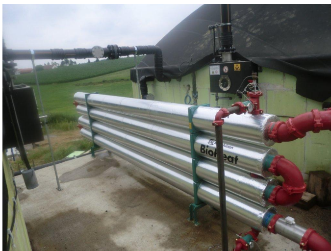
Abbildung 2: Externer Güllewärmetauscher zur Montage im Zu- oder Ablauf des Fermenters
