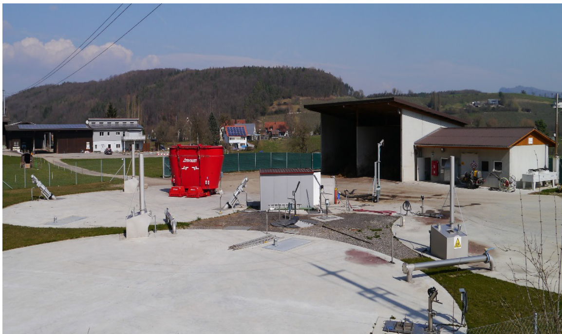
Figure 9: Vue sur l'installation de biogaz avec les cuves de fermentation souterraines
