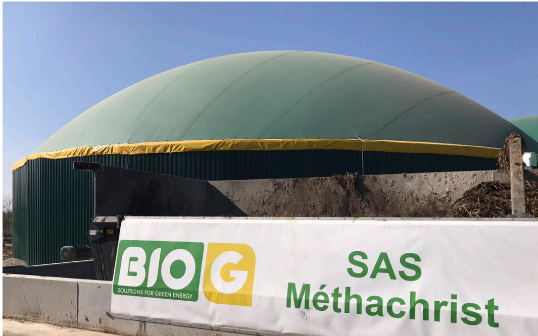
Figure 6: Installation d'Agrogaz Lignerolle SA, Lignerolle, Suisse
