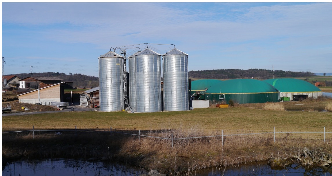
Figure 13: Parc bioénergétique de Guin avec silos de stockage pour les pellets séchés et l'installation de biogaz
