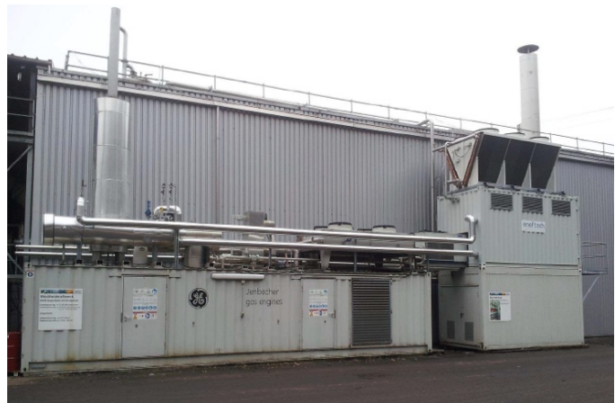
Figure 19 (à droite): Système ORC de l'installation de Kompogas à Klingnau (source: Eneftech)
