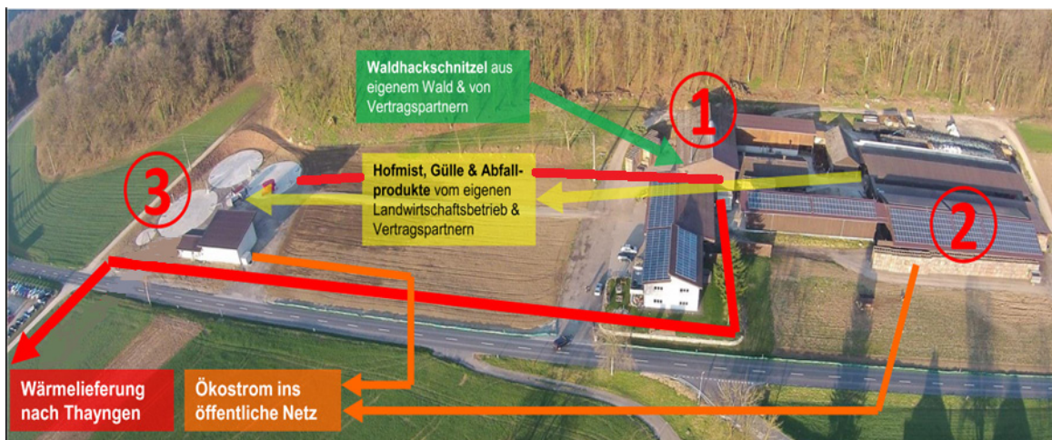
Figure 10: Vue aérienne de l'entreprise agricole «Unterbuck» à Thayngen (SH) avec système de chauffage à copeaux de bois (1), installation photovoltaïque (2) et installation de biogaz avec cogénération (3).
